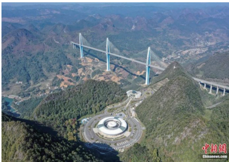
以世界最高混凝土高塔桥“平塘特大桥”为优势打造的贵州平塘“天空之桥”高速服务区。瞿宏伦 摄
