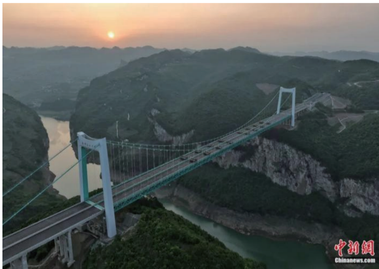
航拍贵州金烽乌江大桥进行1680吨荷载试验。瞿宏伦 摄
