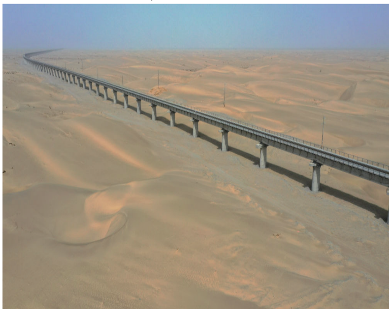
这是2022年5月19日拍摄的和若铁路依木拉克特大桥（无人机照片）。新华社记者 丁磊 摄
