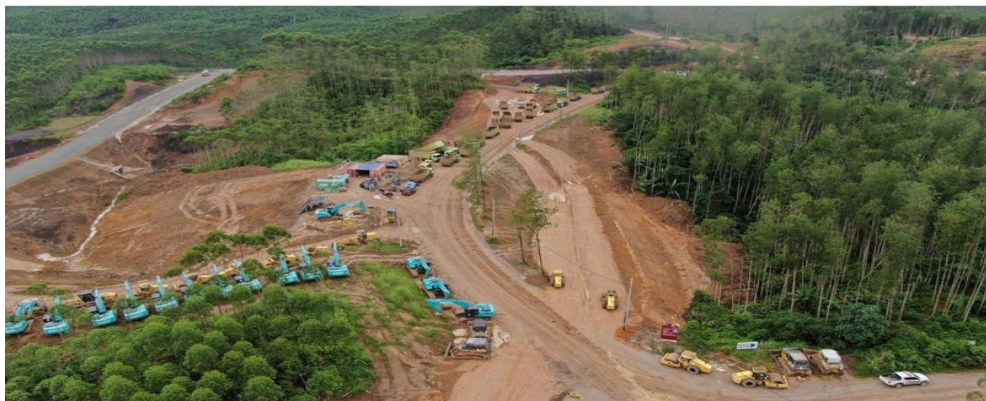
位于加里曼丹的印度尼西亚新首都的建设正在进行中。
