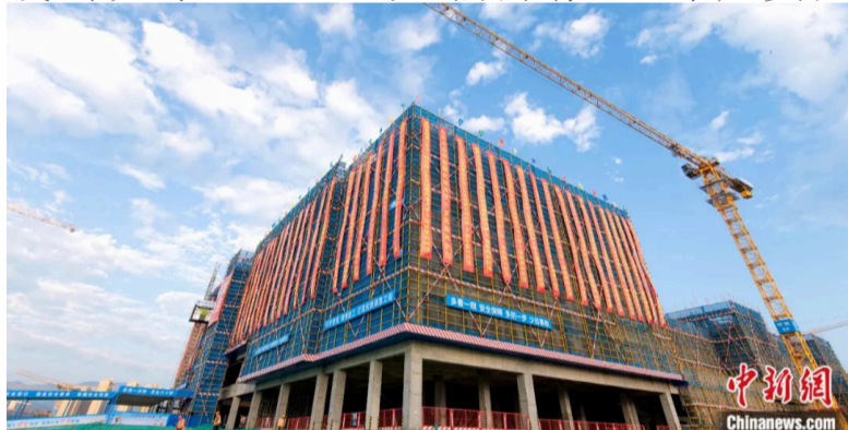
明德堂及行政楼主体结构。倪跃嘉 摄
