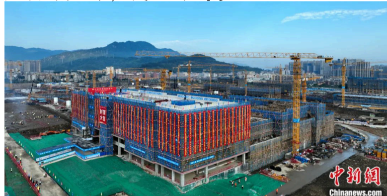
2022年11月，明德堂及行政楼主体结构封顶。倪跃嘉 摄
