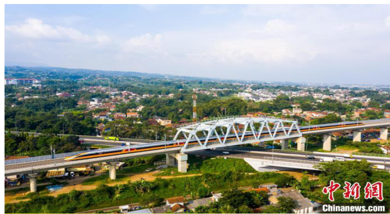
雅万高铁开始联调联试。中国铁路国际有限公司供图
