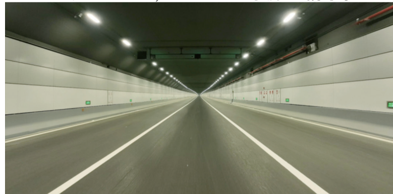
大连湾海底隧道内部。 (大连湾海底隧道有限公司供图)
