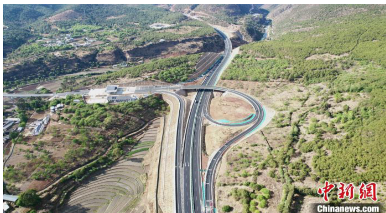
图为鹤剑兰高速公路沙溪支线。 云南省建设投资控股集团有限公司供图
