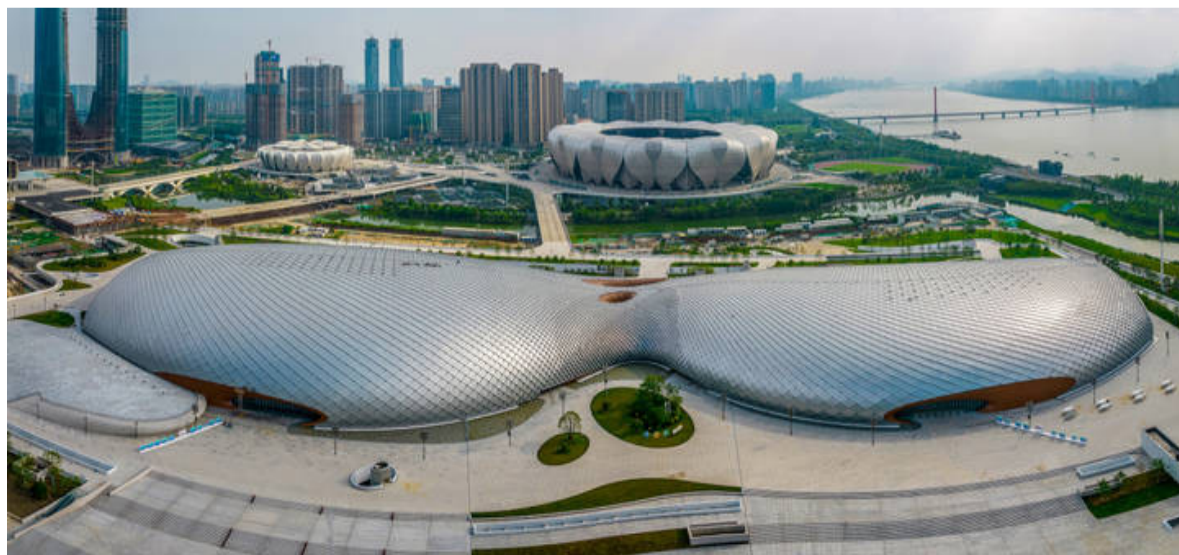
杭州奥体中心内体育馆、游泳馆双馆合一
