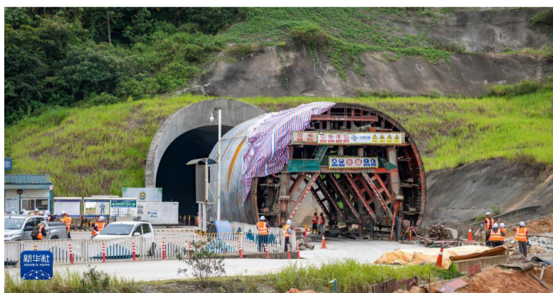
这是3月6日在马来西亚彭亨州拍摄的马来西亚东海岸铁路（马东铁）关丹隧道施工现场。新华社发（张纹综摄）
