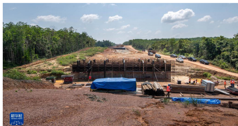
3月6日，工人在马来西亚彭亨州金马梳的马来西亚东海岸铁路（马东铁）沿线施工。新华社发（张纹综摄）
