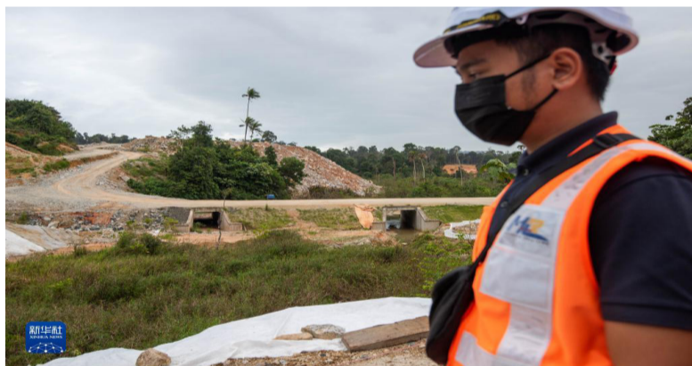
这是3月6日在马来西亚彭亨州拍摄的马来西亚东海岸铁路（马东铁）关丹隧道施工现场附近设立的野生动物穿越通道。新华社发（张纹综摄）
