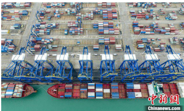
图为航拍海南洋浦国际集装箱码头。骆云飞摄
