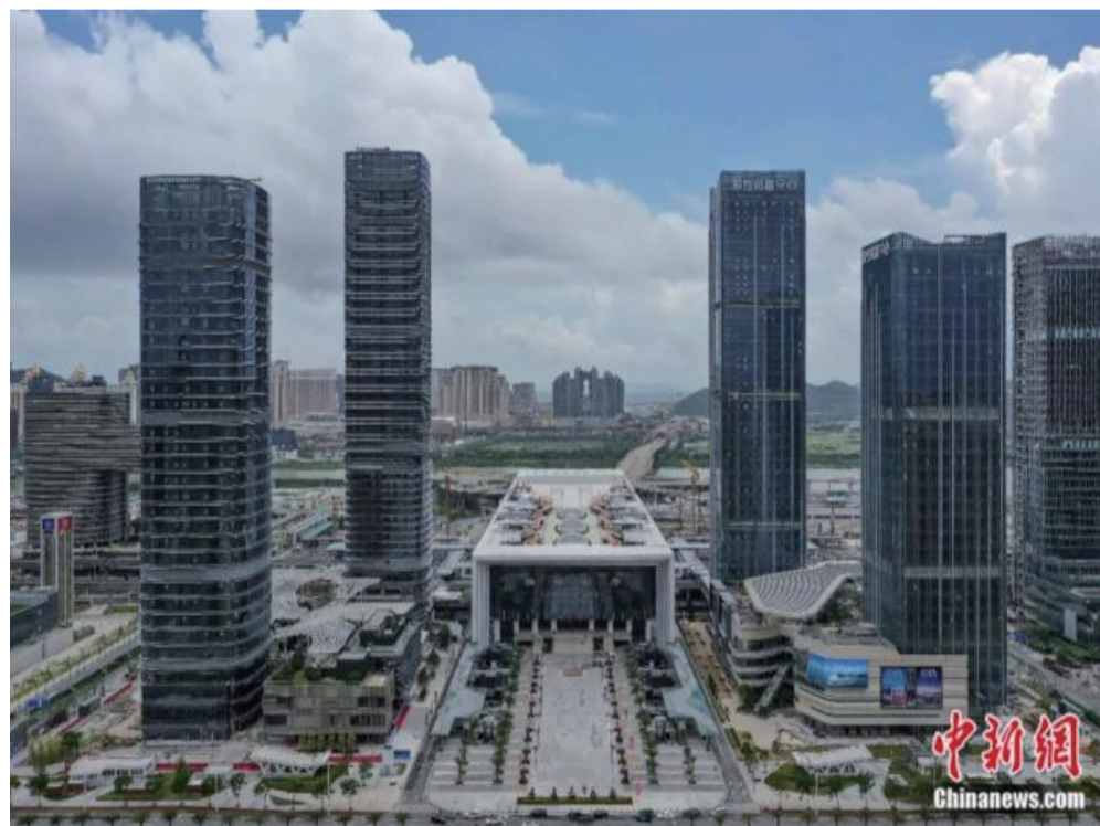
航拍横琴口岸新旅检大楼。 (无人机照片)陈骥旻 摄
