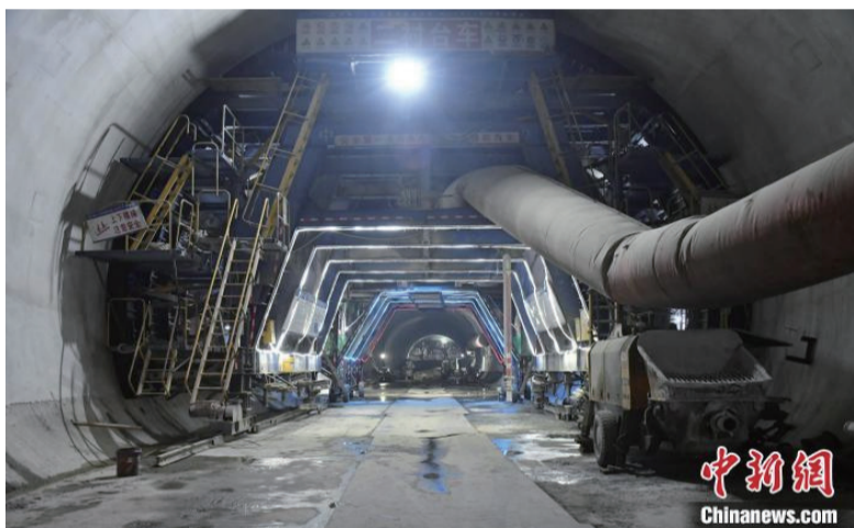
下黄田隧道施工现场 周李科 摄
