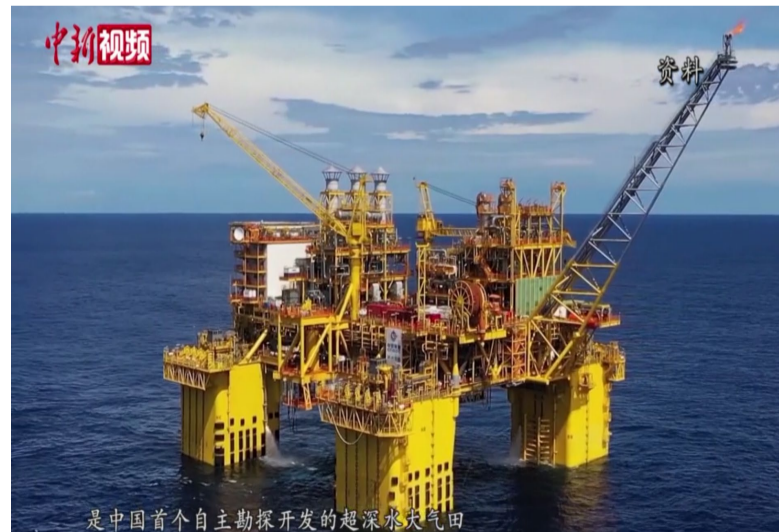
“深海一号”是中国自主研发建造的全球首座10万吨级深水半潜式生产储油平台
