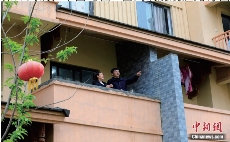
四川昭觉，位于海拔1400多米的悬崖之上的阿土列尔村享受到易地扶贫搬迁政策，村民某色尔布(右)与妻子在新居的阳台上眺望。王磊 摄
