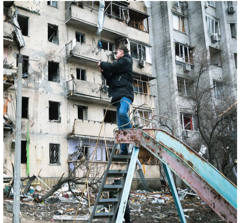
在乌克兰基辅，一名男子在拍摄一座公寓楼，这座公寓楼在不断升级的冲突中遭到严重破坏。
