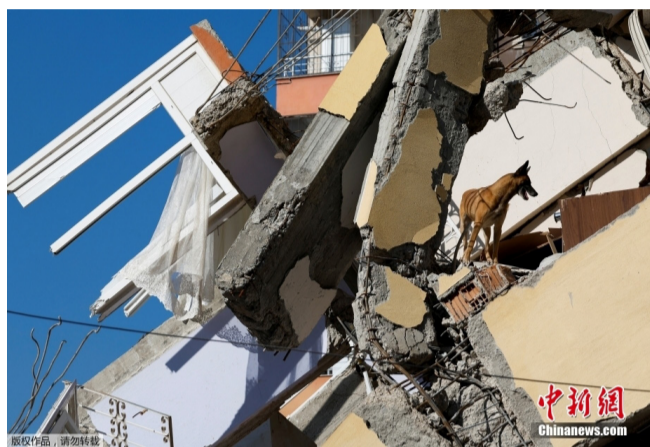
当地时间2月8日，土耳其哈塔伊的刻里罕（Kirikhan）小镇，来自德国国际救援队的搜救犬在地震后的建筑废墟中寻找幸存者。
