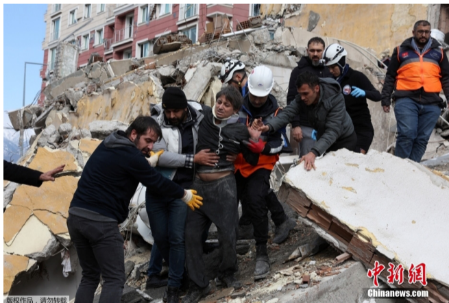
当地时间2月7日，土耳其哈塔伊，救援人员从倒塌的建筑中救出一名被困者。
