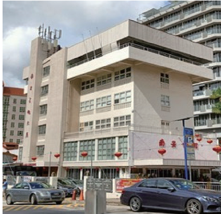
南安会馆大厦
