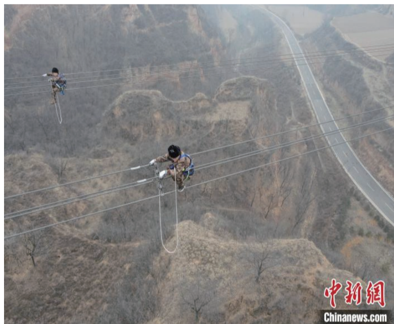
图为电力运维人员正在高空中进行走线作业(视频截图)。国网山西超高压输电公司供图
