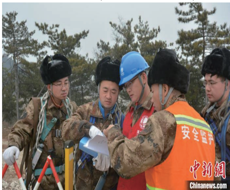
春节前夕，国网山西超高压输电公司运检四分部段晓鹏等运维人员对500千伏潞辛Ⅱ线进行地面巡视工作。 陈松波 摄
