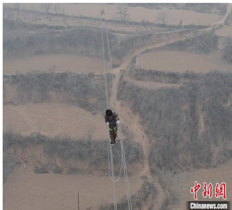
图为电力运维人员正在60余米高空“走钢丝”(视频截图)。国网山西超高压输电公司供图
