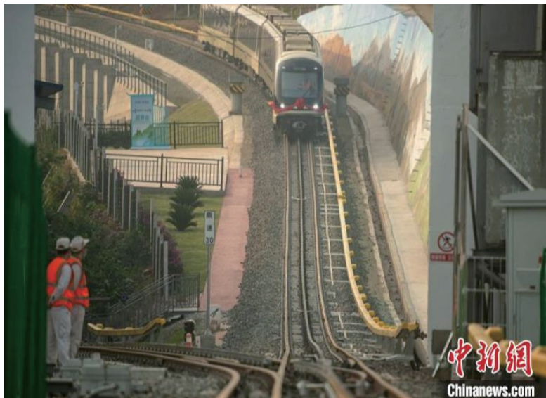
试验线上正在运行下坡的齿轨列车。刘忠俊 摄
