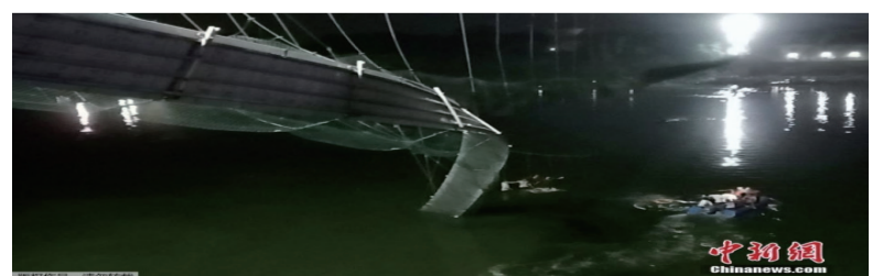
当地时间10月30日，印度西部古吉拉特邦一座拉索桥突然断裂，事发时有数百人正在桥上。图为事故现场。
