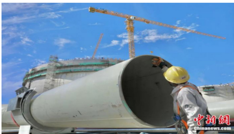
2022年10月，天津LNG接收站二期项目有序进行中，确保5#、6#储罐供暖季前投用。中新社发 王军 摄
