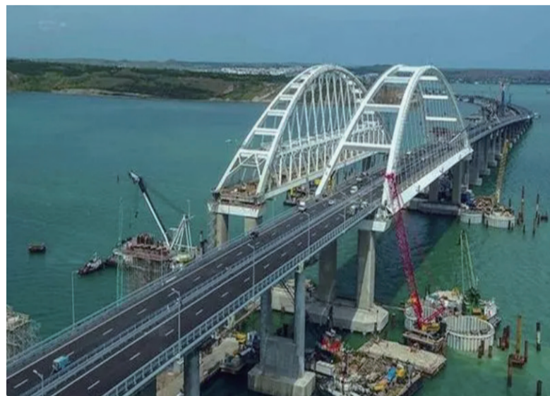
克里米亚大桥
