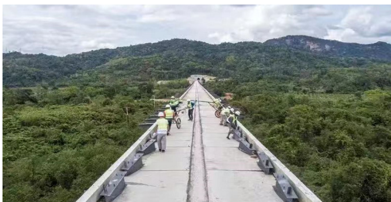
2020年4月25日，在老挝首都万象北部的中国电建水电十局中老铁路项目工地，中国管理、技术人员参加体力劳动，进行高架桥桥面系施工。（新华社发）
