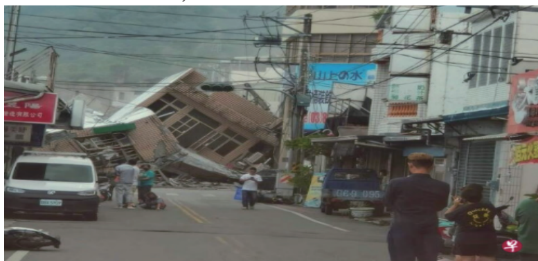
在规模6.8级的地震发生后，台湾东部花莲玉里镇一栋大楼倒塌。
