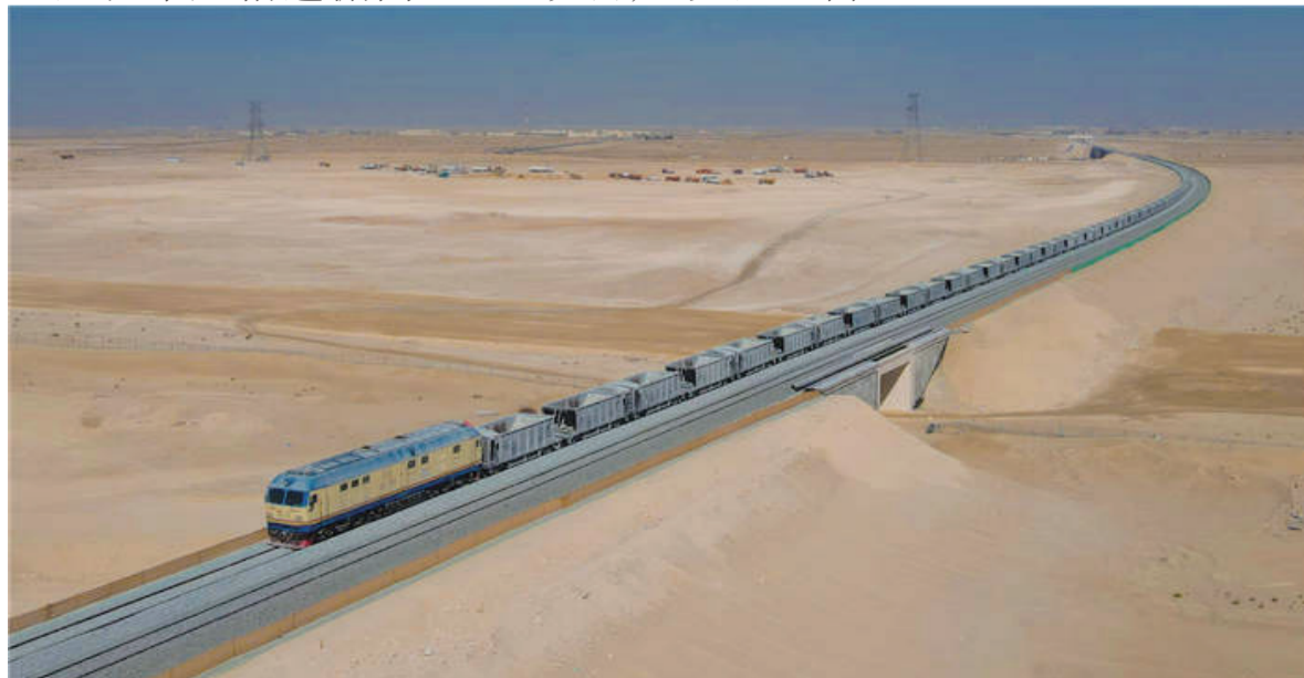
道砟车行驶在已完成双线铺轨的轨道上。 中国土木工程集团有限公司供图
