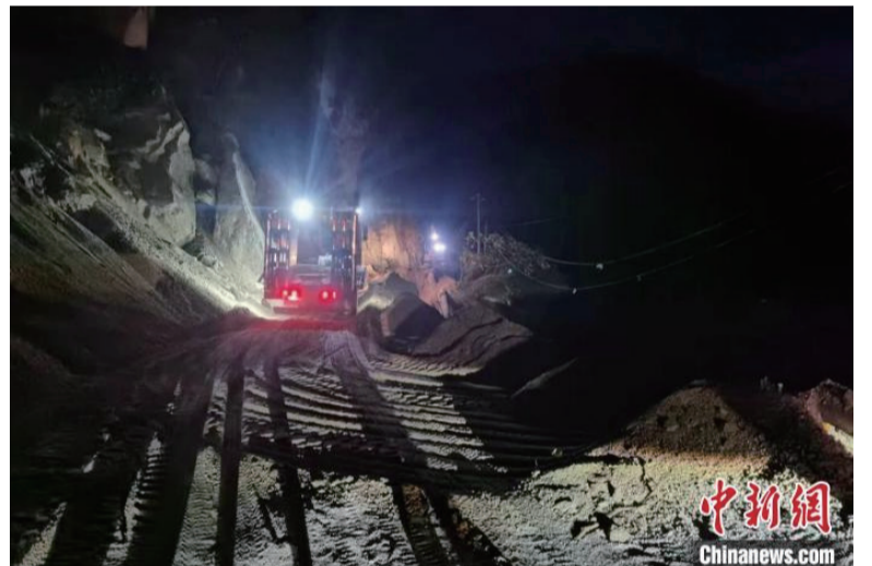
国道108线雅安石棉救援道路全线抢通
