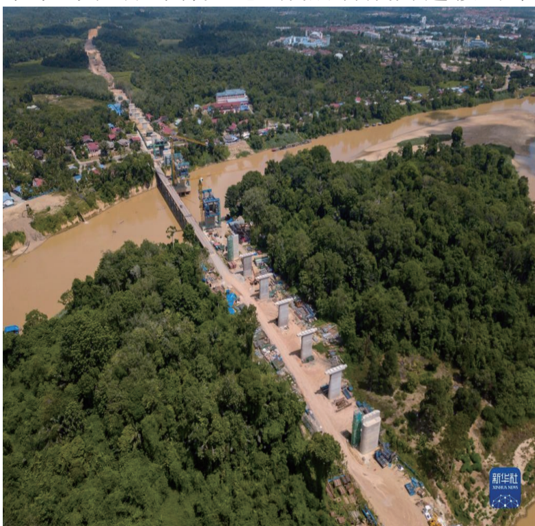
这是7月25日在马来西亚彭亨州淡马鲁县拍摄的建设中的马东铁项目30号桥（无人机照片）。新华社记者朱炜摄
