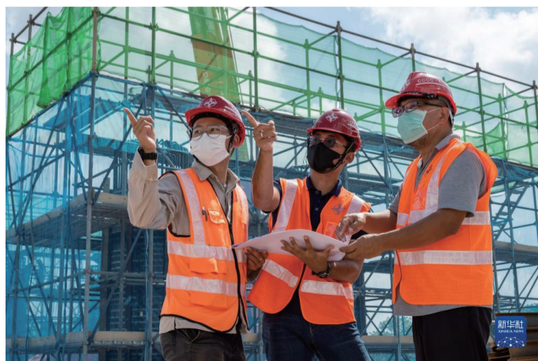
7月25日，西亚赫明（中）在位于马来西亚彭亨州的马东铁项目六分部施工现场工作。新华社记者朱炜摄
