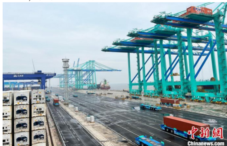
图为天津港北疆港区C段智能化集装箱码头。 王君妍 摄
