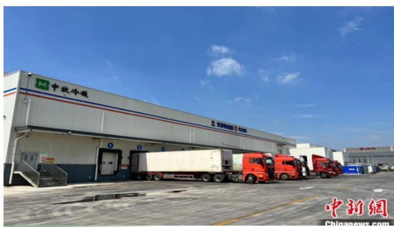
图为天津物流园项目冷库。 王君妍 摄
