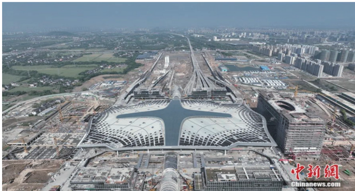
2022年4月，航拍杭州西站屋顶的光伏组件。杭州西站光伏发电项目面积1.5万平方米，建成后预计年均发电量达231万度，每年可节约标准煤830余吨，减少二氧化碳排放量2300余吨。中新社记者王刚摄
