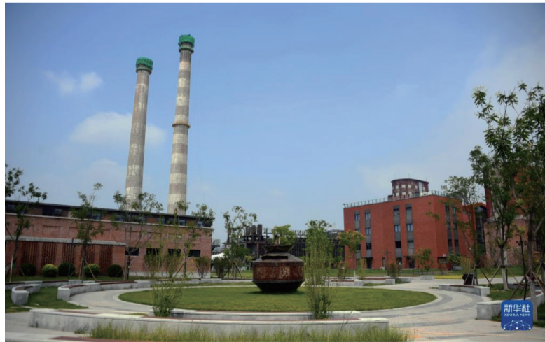
8月1日拍摄的首钢园区。
