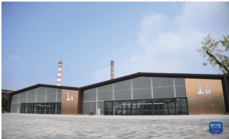
8月1日拍摄的2022年服贸会首钢园区场馆外景。
