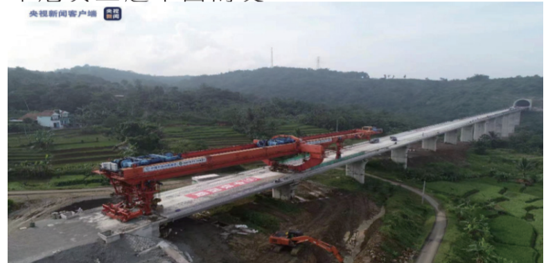
2022年6月13日，印尼雅万高铁4号梁场箱梁架设完成
