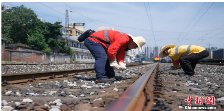
工人们正在进行复紧螺栓作业。何蓬磊 摄
