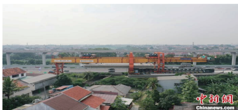
图为最后一榦箱梁架设。(无人机照片) 陶塬羽 摄
