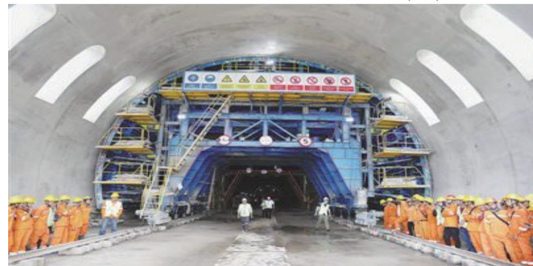
雅万高铁瓦利尼隧道入口。 人民日报记者 徐伟摄
