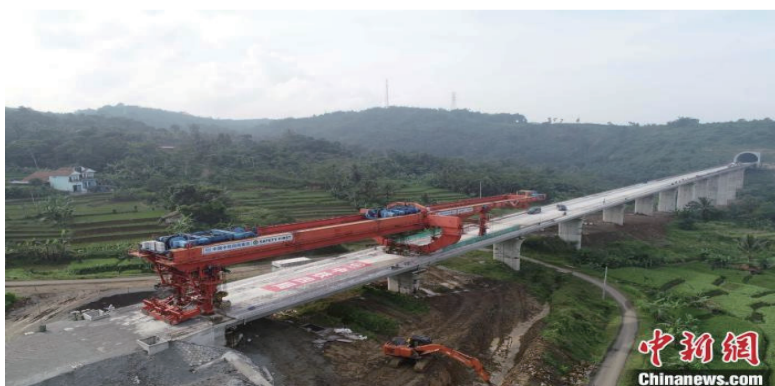
图为箱梁架设完成。 (航拍照片) 王增堃 摄
