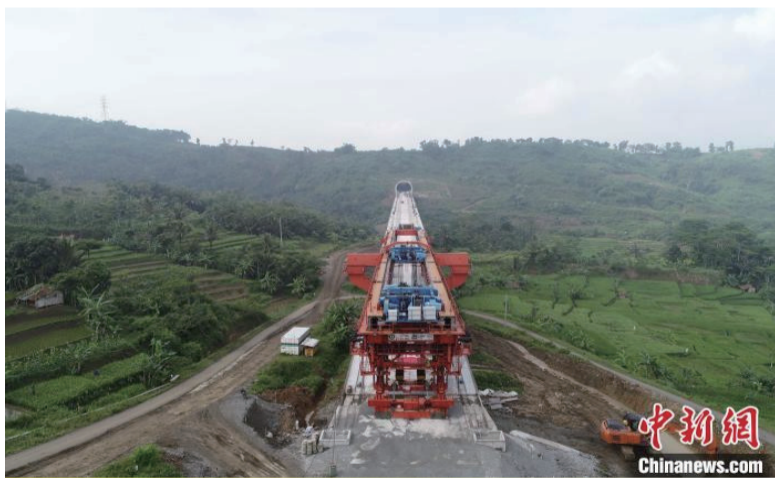
图为箱梁架设完成。 (航拍照片) 王增堃 摄
