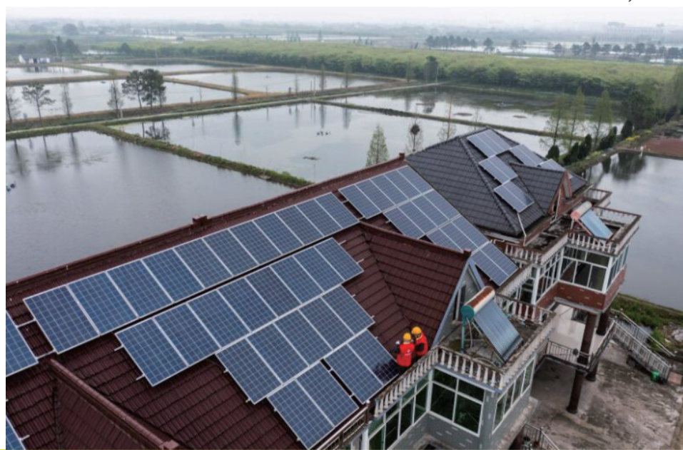
地方保护政策导致光伏行业的“路条”倒卖问题。图为浙江省湖州市齐星村的工人3月31日为当地居民的太阳能屋顶光伏电站巡检。（新华社）
