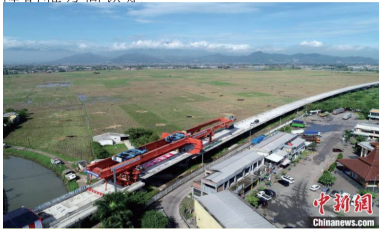
图为箱梁架设现场(无人机照片)。王增堃 摄
