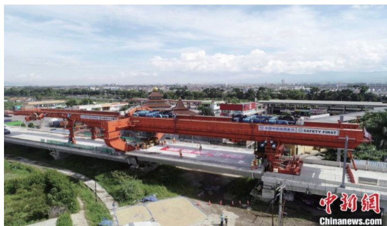
图为箱梁架设现场(无人机照片)。王增堃 摄
