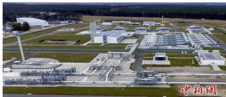
资料图：“北溪-2”天然气管道项目登陆设施管道。
