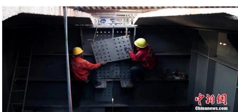
4月6日,施工人员正在新建福厦高铁安海湾特大桥上施工。中新社发 张伟 摄 图片来源: CNSphoto
