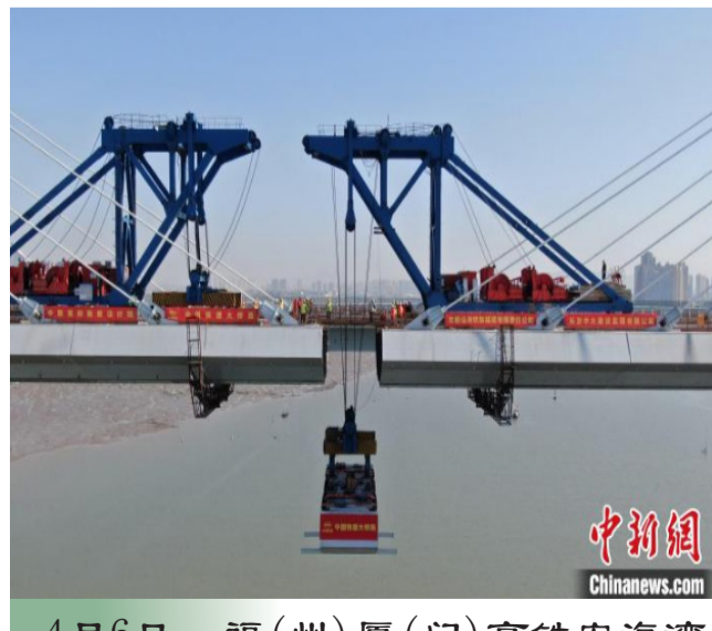
4月6日,福(州)厦(门)高铁安海湾特大桥梁最后一节钢箱梁正在吊装。 张伟 摄
