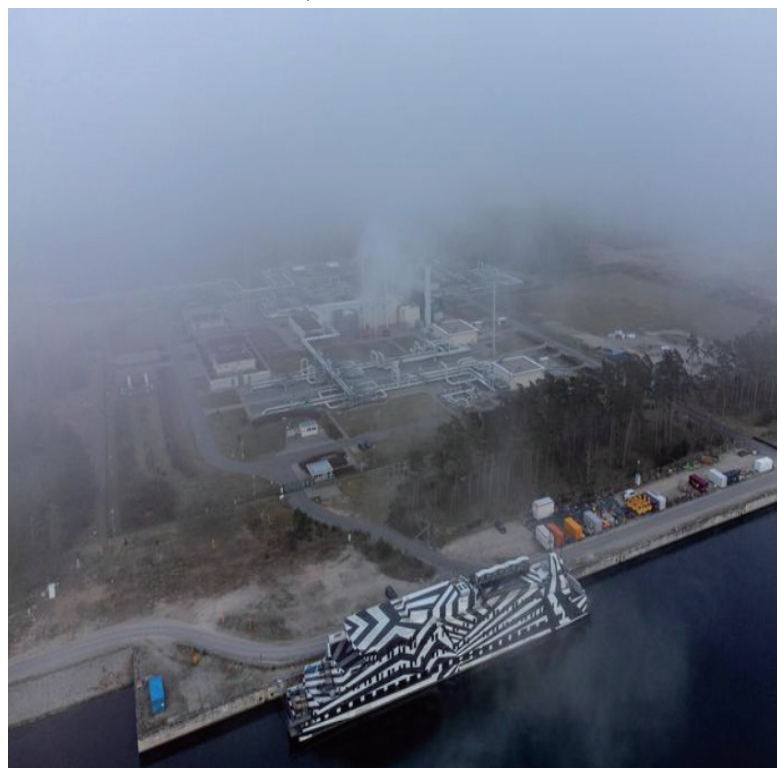
↑ 资料图。德国卢布明北溪1号天然气管道接收站
