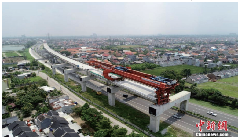
当地时间3月31日, 印尼雅万高铁又一控制性高风险工程, 全线最长跨高速公路箱梁架设顺利完成, 为雅万高铁由万隆向雅加达方向铺轨施工创造了必要条件。中新社发 王增 摄
