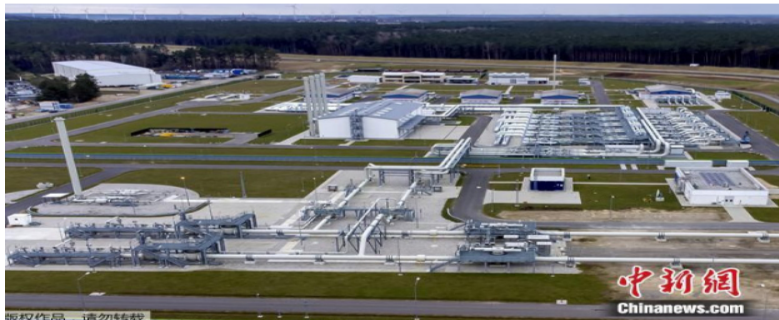
资料图：“北溪-2”天然气管道项目登陆设施的管道。
