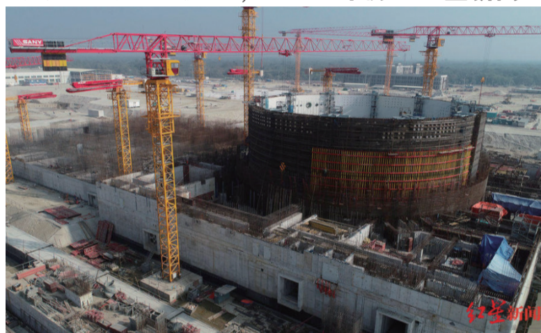
▲正在建设中的卢普尔核电站
