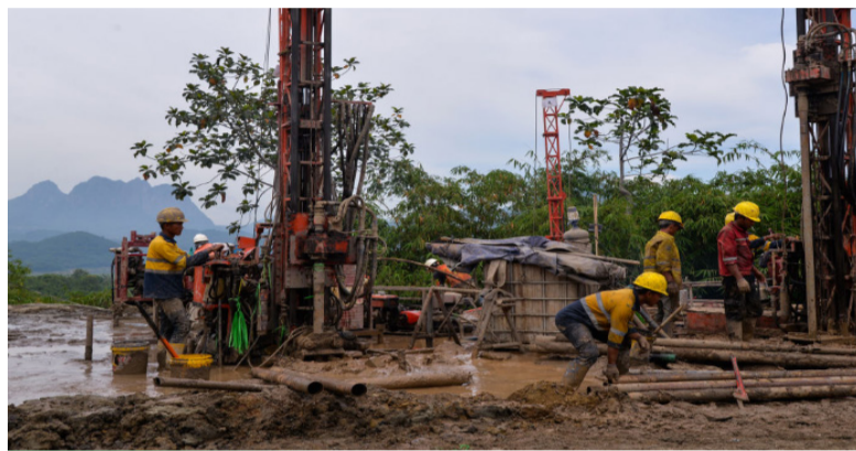
1月28日，在印度尼西亚西爪哇省普哇加达县，工作人员在雅万高铁2号隧道地表灌浆施工现场作业。(新华社记者徐钦摄)
