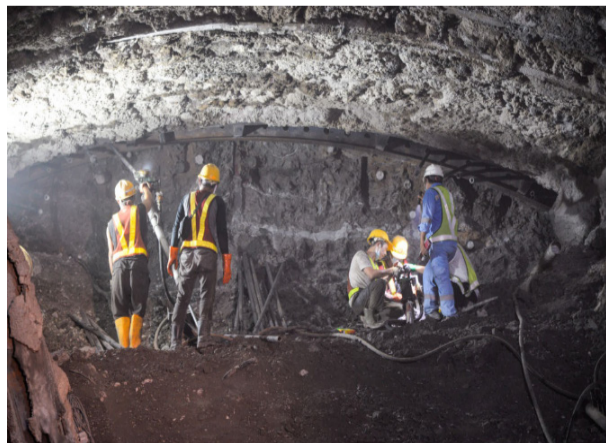
1月28日，在印度尼西亚西爪哇省普哇加达县，工作人员在雅万高铁2号隧道内作业。(新华社记者徐钦摄)
