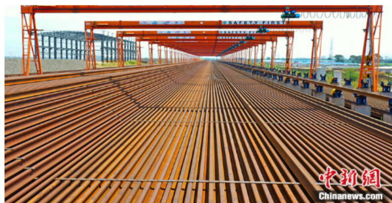
资料图为8月30日，万隆雅万高铁铺轨基地，所有从中国进口的50米钢轨将在此焊接成500米长钢轨投入使用。(无人机照片) 中新社发 桑军阳 摄
