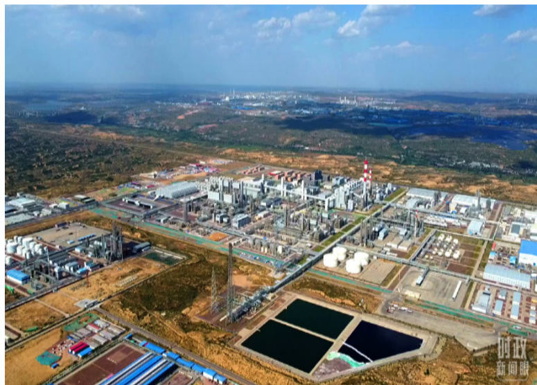
俯瞰国能榆林化工有限公司，管廊栉比、塔罐林立。（总台记者白龙飞拍摄）
