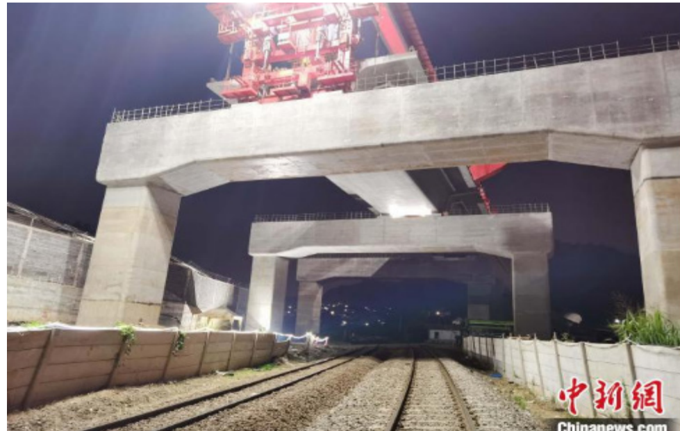
图为箱梁架设施工。 王增堃 摄
