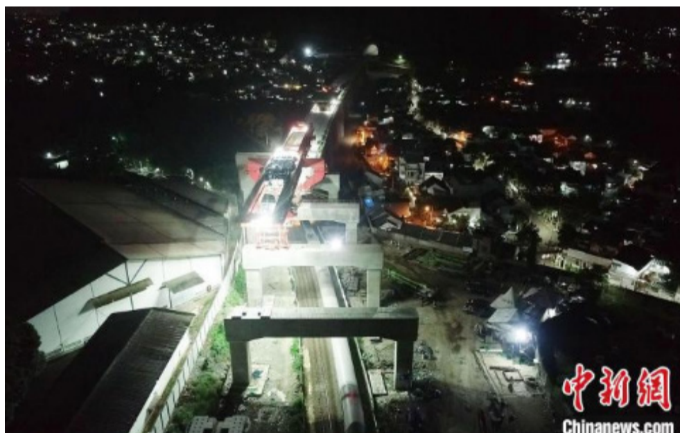
22日凌晨,印尼雅万高铁全线唯一一处上跨印尼既有铁路箱梁完成架设。 王增堃 摄
