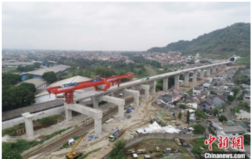
图为箱梁完成架设。 王增堃 摄
