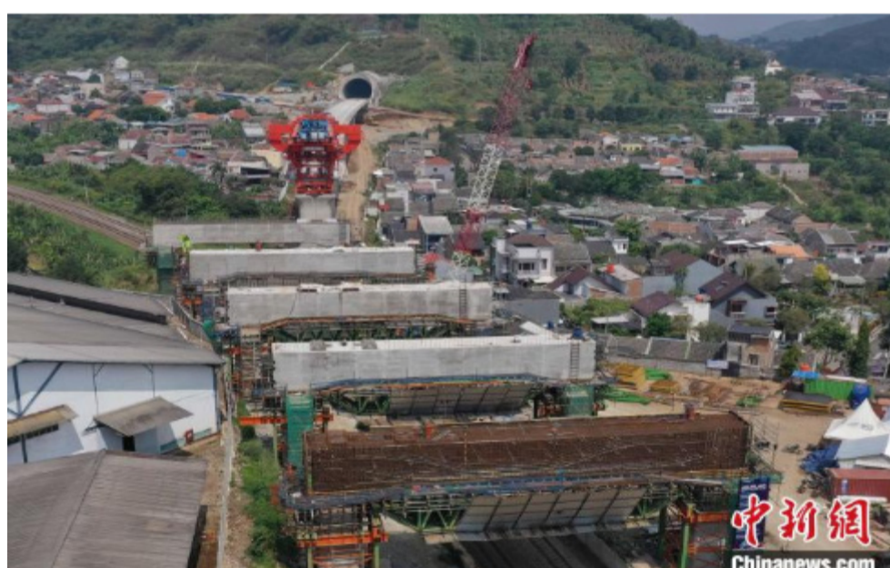
图为箱梁架设施工。 王增堃 摄
