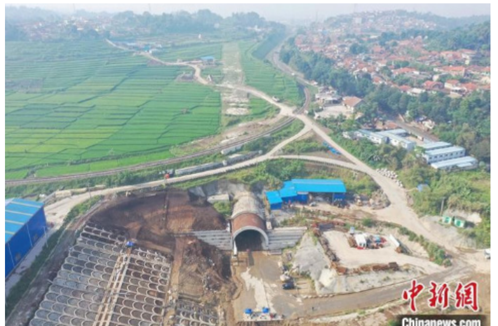
图为8月6日拍摄的10号隧道进口。中新社发 陈波 摄
